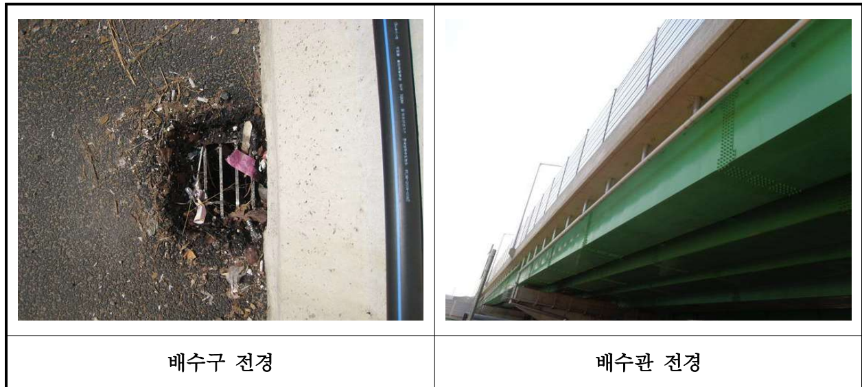
【사진 23.3.21】 배수시설 전경
