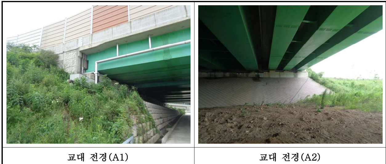
【사진 23.3.8】 교대 전경
