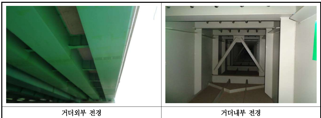
【사진 23.3.4】 거더 전경
