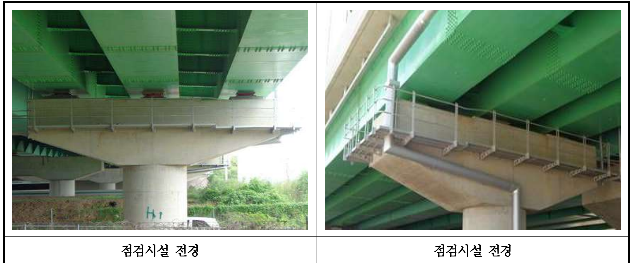
【사진 23.3.25】 교량 점검시설 전경
