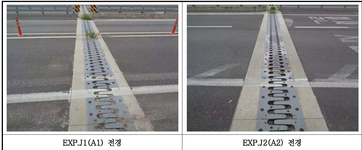
【사진 23.3.16】 신축이음장치 전경
