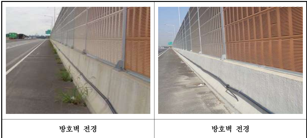
【사진 23.3.23】 방호벽 전경
