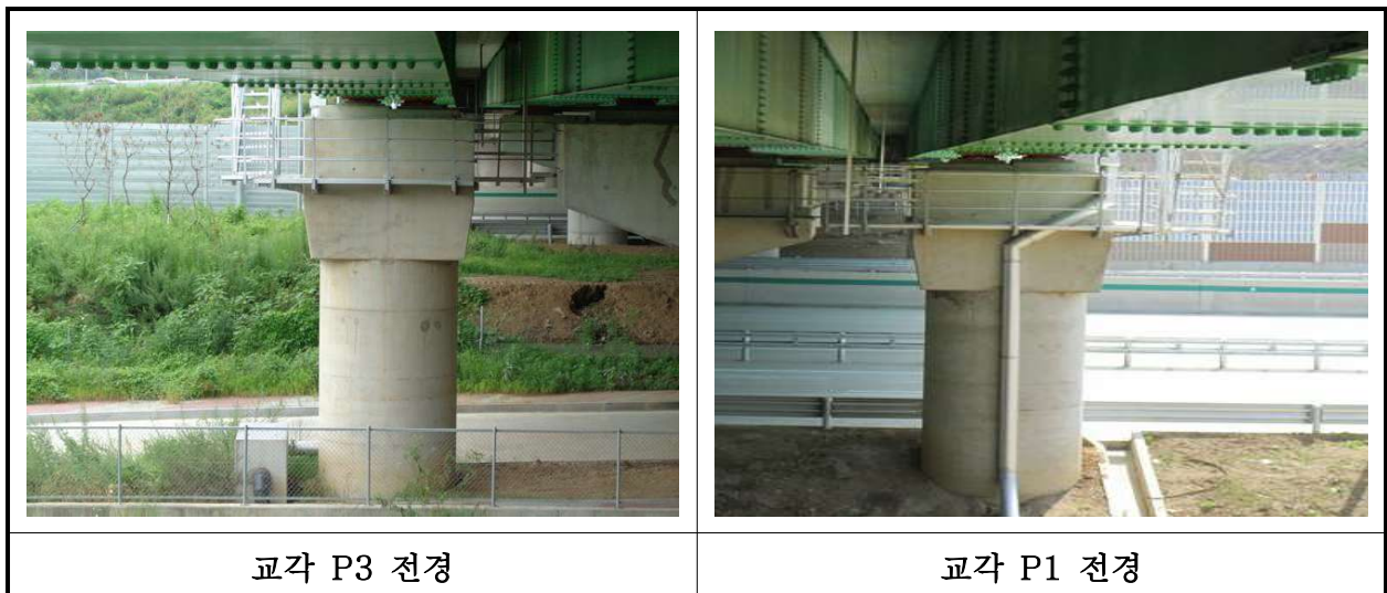
【사진 23.3.10】 교각 전경
