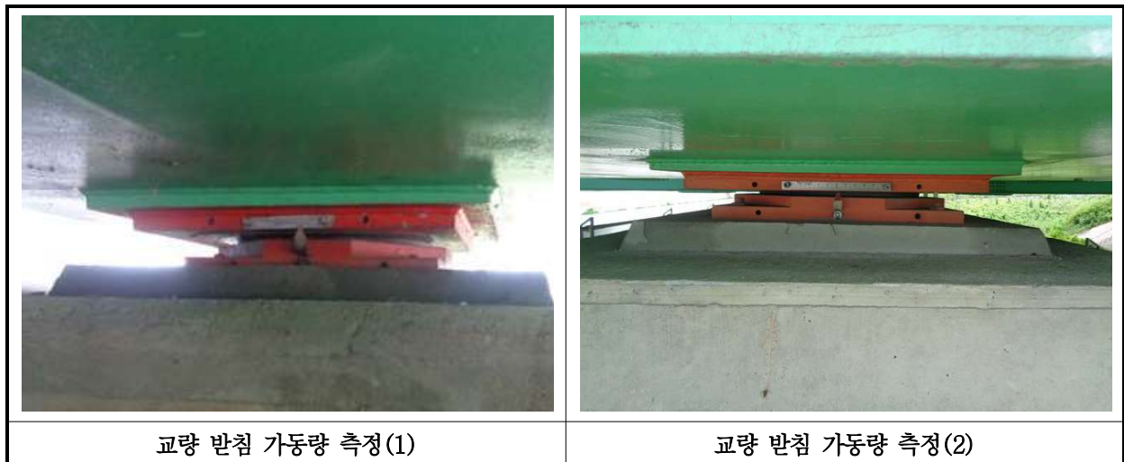
【사진 23.3.15】교량받침 이동량 측정
