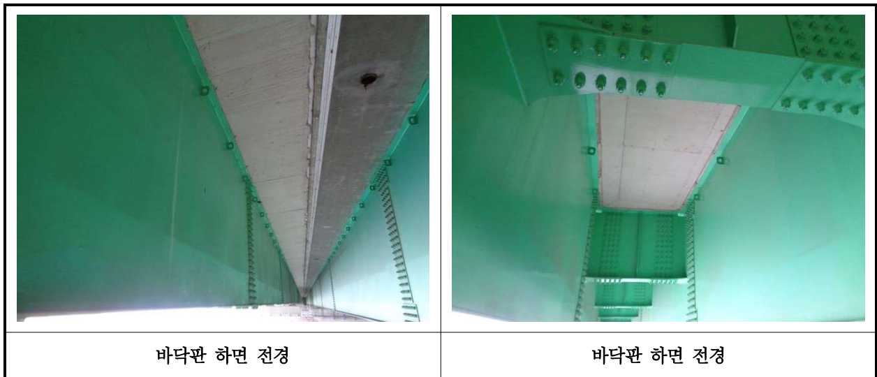
【사진 23.3.2】 바닥판하면 전경
