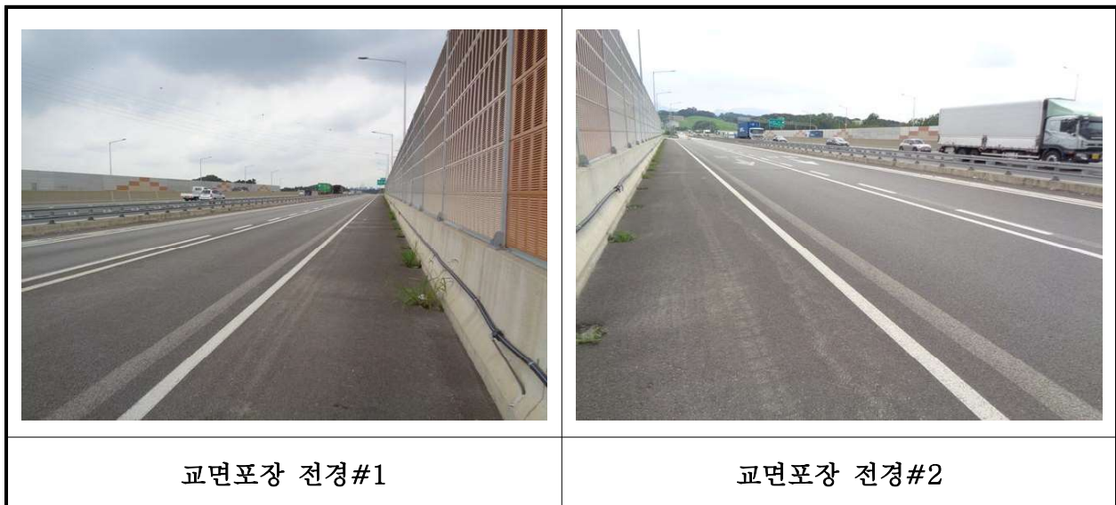
【사진 23.3.19】 교면포장 전경
