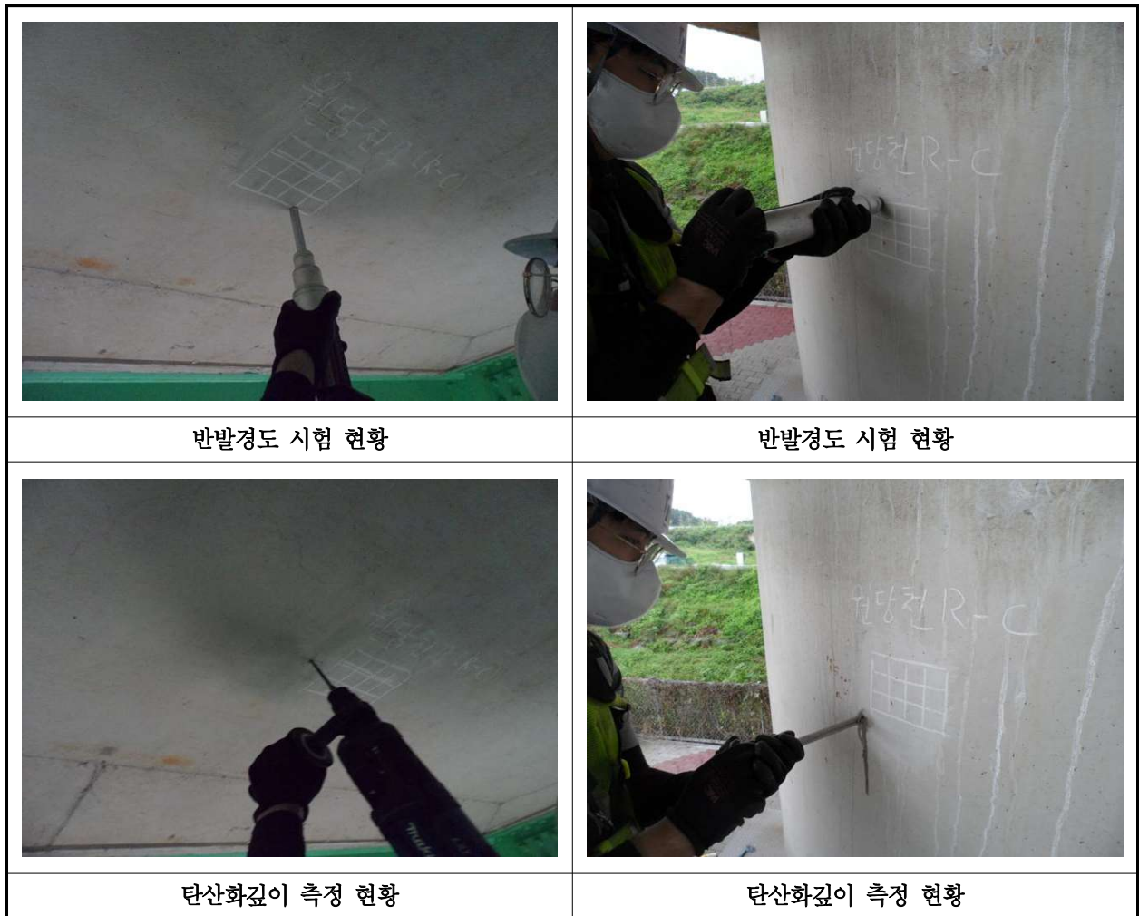
【사진 23.4.1】 콘크리트 내구성조사 현황
