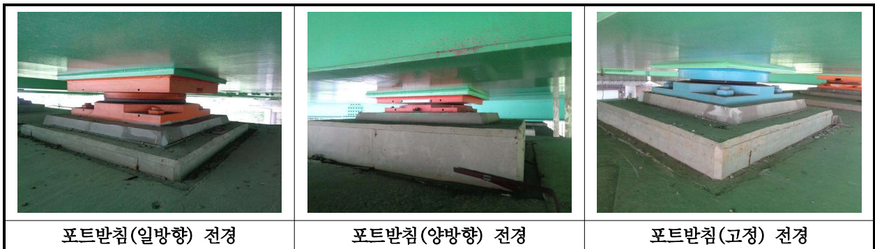
【사진 23.3.12】 교량받침 전경
